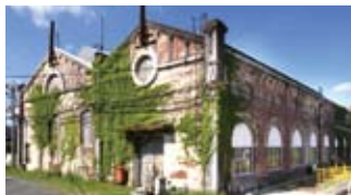
世界遺産・遠賀川水源地ポンプ室
