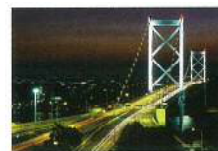
関門橋 関門自動車道
