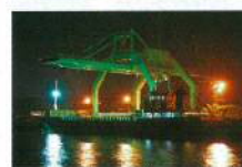
ガントリークレーン 日本製鉄(株) 八幡製鉄所 [八幡地区]
