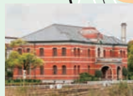
官営八幡製鐵所 旧本事務所 （眺望スペースより）
